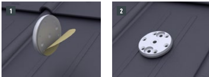
Figure 7 • Pose des supports solaires Vario et Fix
