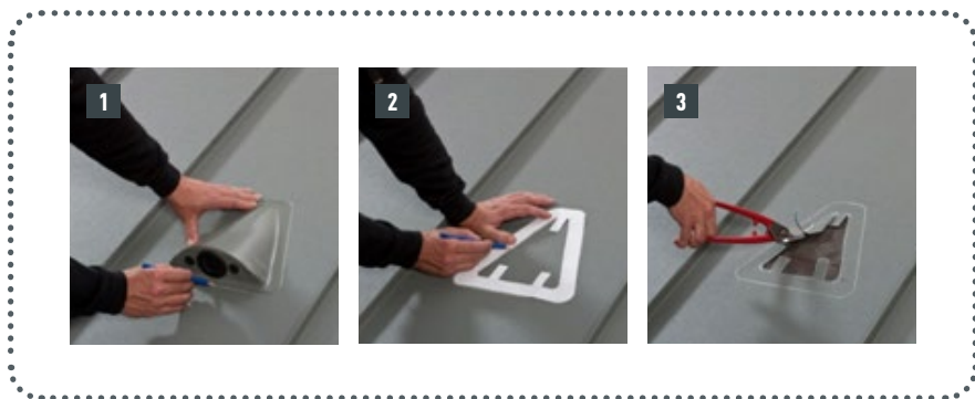
Figure 69 • Pose de la chatière pour panneaux solaires
