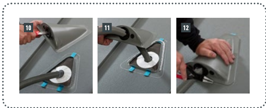
Figure 72 - Pose de la chatière pour panneaux solaires
