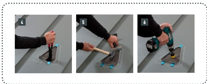
Figure 70 • Pose de la chatière pour panneaux solaires
