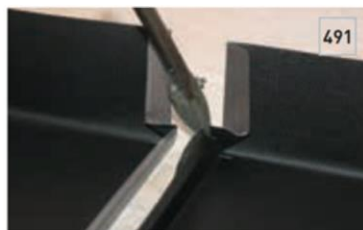
Figure 15 – Réalisation d'une grisonne (pente 5% minimum)
