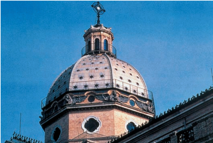
Posé depuis plus de 100 ans et toujours aussi agréable à regarder : Le toit de l’église de San Gioacchino a été réalisé en aluminium en 1898.
