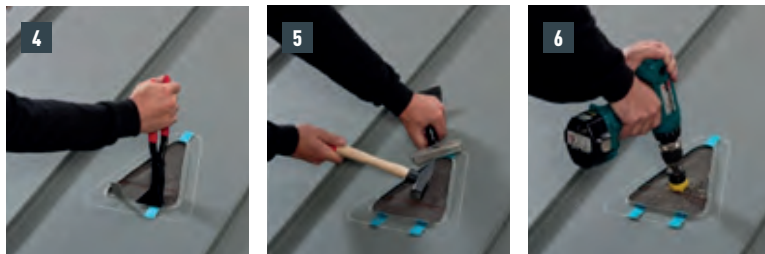
Figure 72 • Pose de la chatière pour panneaux solaires
