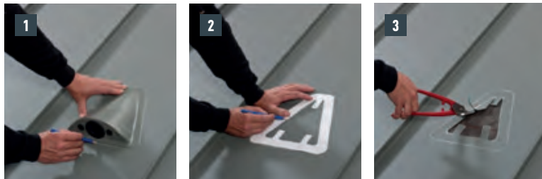
Figure 71 • Pose de la chatière pour panneaux solaires
