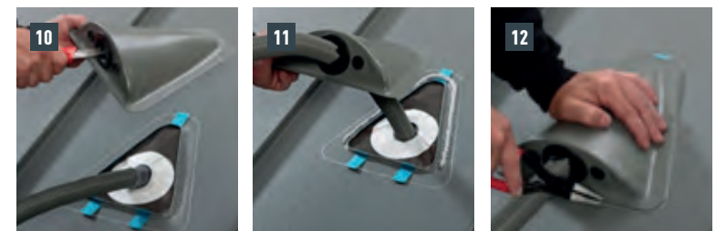
Figure 74 • Pose de la chatière pour panneaux solaires
