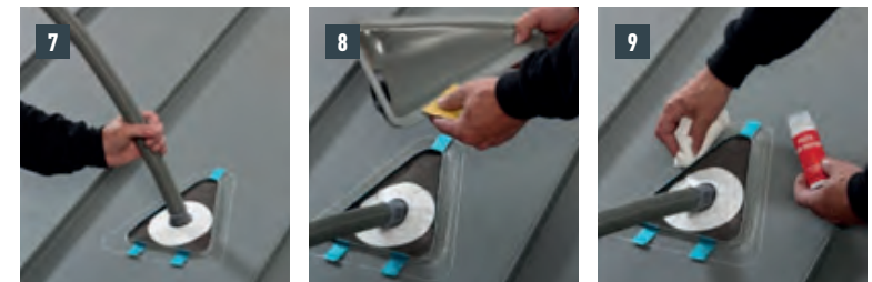
Figure 73 • Pose de la chatière pour panneaux solaires
