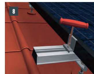
Figure 68 • Fixation des accessoires pour panneaux solaires
