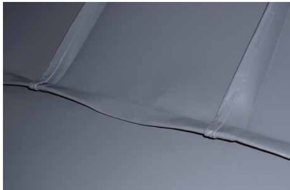
Figure 39 • Positionnement des agrafes autour des pénétrations
